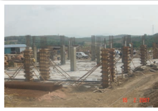
Pembinaan Aras 1 Building Phase 1
