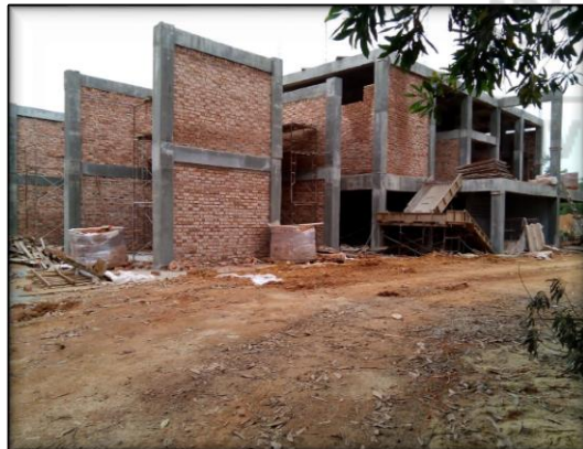
PEMBINAAN PENCAWANG PEMBAHAGI UTAMA ELEKTRIK 33kV
