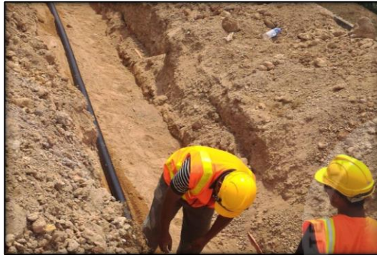
KERJA MENAIKTARAF BEKALAN ELEKTRIK DARI 11kV KEPADA 33kV
