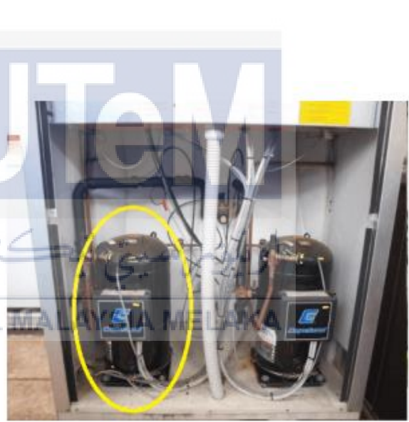
Figure 2.3(d) : Scroll type compressor
