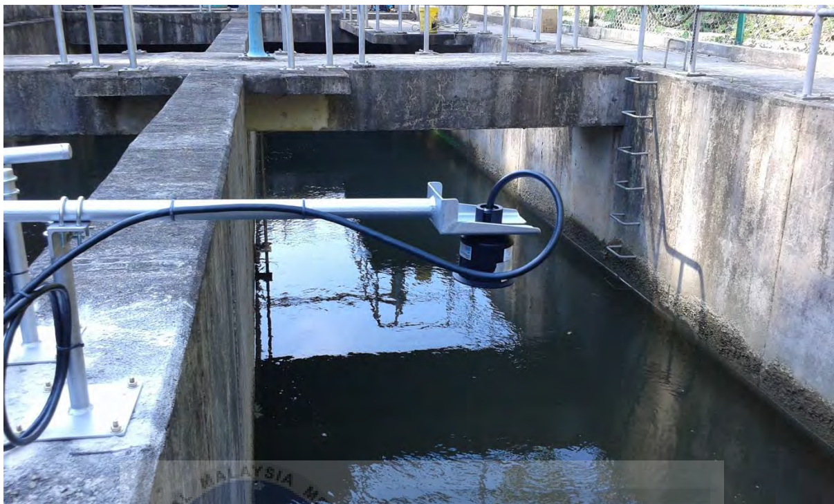
Rajah 3.6 : Laser Flow Sensor Halaju Bukan-sentuh telah siap dipasang (Sumber: Persendirian)
