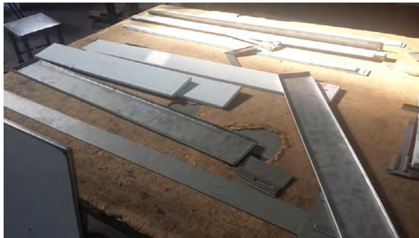
Rajah 4.27 : Panel yang mengalami proses pembengkokan bersudut
