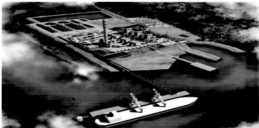
Rajah 2.7 Menunjukkan Gambaran dari udara Loji kuasa di Tanjung Bin
